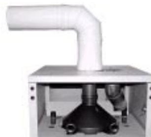
Fig. 7c. Przewody koncentryczne 80/125 mm
